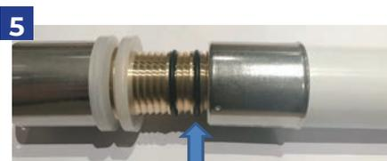
Luego, inserte el cuerpo del accesorio en el tubo con el casquillo. Insértelo cuidadosamente y verifique visualmente que las juntas tóricas no estén dañadas ni se dañen en el montaje.
