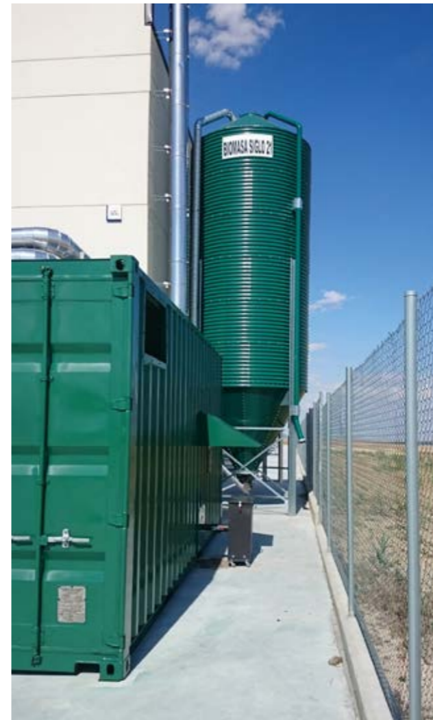
Instalación de un contenedor y silo de 35 Tm
