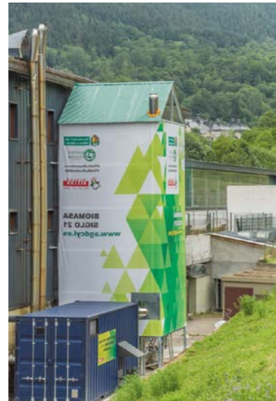
Instalación de un contenedor y silo de 35 Tm en un ambiente rural-urbano.
