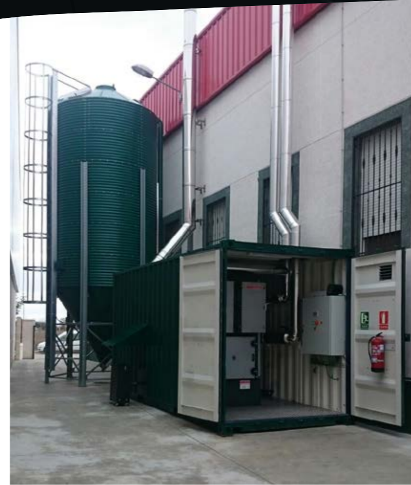
Instalación de un contenedor y silo en una nave industrial
