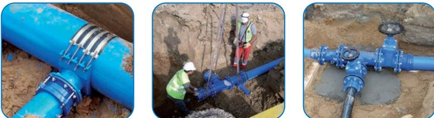
Accesorios de fundición dúctil con sistema brida
