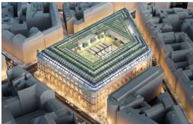
Poste du Louvre - Francia - Clima Canal
