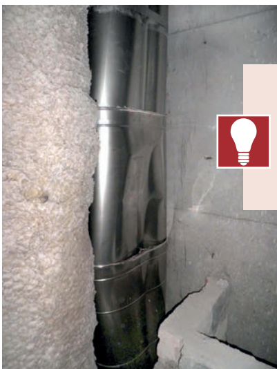
Durch Joukowski Stoß beschädigte Abgasanlage Flue gas system damaged by a Joukowski pressure surge
