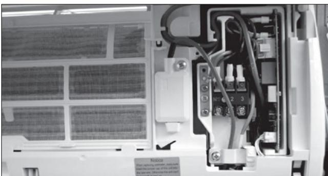
3. Retire el clip del cable, saque el cable de conexión WiFi de la caja electrónica y conéctelo al puerto de conexión del módulo WiFi.
