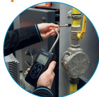
DETECCIÓN DE FUGAS DE GAS COMBUSTIBLE ANTES DEL QUEMADOR DE UNA CALDERA
