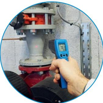
CONTROL DE TEMPERATURA EN LA ENTRADA Y LA SALIDA DE UNA RED DE AGUA CALIENTE SANITARIA
