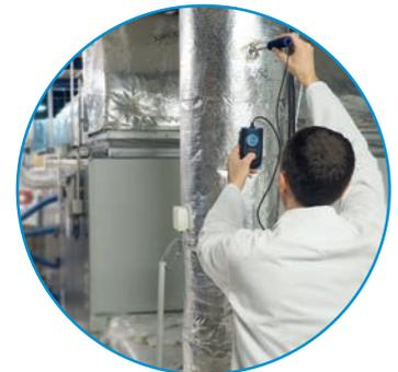
TEMPERATURA, VELOCIDAD Y CAUDAL DE AIRE EN UN CONDUCTO
