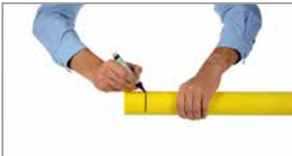
7. Marcar la profundidad de inserción del tubo.
