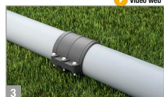
3. Apretar los tornillos progresiva y alternativamente, dejando la instalación operativa y lista para su puesta en carga. / The bolts must be tightened progressively and alternatively, then the installation is ready to keep working at the normal pressure.
