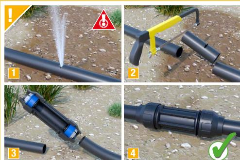
La secuencia nos muestra una reparación realizada con manguito de reparación. Ante una rotura (imagen 1), se procede a sanear la tubería, (2). A continuación, gracias al diseño de mayor longitud y sin topes del manguito de reparación, se puede reparar fácilmente (3) y seguir trabajando de forma inmediata, (4).
