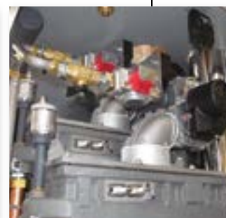
2 grupos: ventilador, válvula gas modulante, quemador premix
