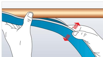
Ajuste la coquilla Armaflex colocada para garantizar que se puede acceder sin problemas al corte.
