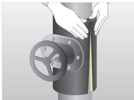
Corte el recubrimiento de la válvula y encájelo sobre ésta. Aplique una capa fina de adhesivo Armaflex en todas las costuras de fijación de la cubierta de la válvula. Permita que se seque ligeramente ("prueba de la uña"), ajústela y luego presione con firmeza.
