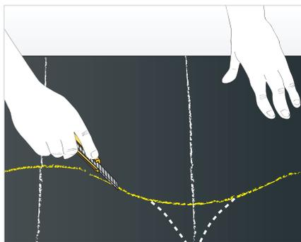
Empleando como radio la diferencia entre las dos alturas, marque 5 arcos alrededor de las intersecciones de las líneas y una los arcos con una raya continua. Corte la sección formada en la plancha.
