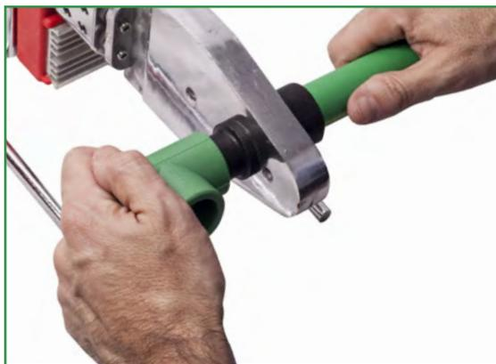
Introducir simultáneamente, sin girar el extremo de la tubería hasta la marca que señala la profundidad de inserción y el accesorio hasta su final, en las matrices de calentamiento.
