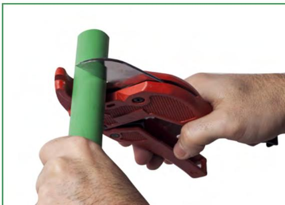
Haciendo uso de una tijera cortatubos adecuada se practica un corte en la tubería, debiendo ser este limpio y lo más perpendicular posible. Marcar la profundidad de fusión en la tubería.
