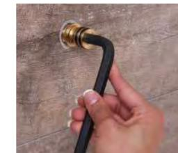
Colocar el rociador y fijar mediante el tornillo superior.
