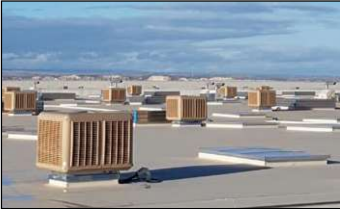
Instalaciones de Pikolin, vista del tejado
