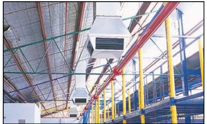
Los evaporativos en locales industriales mejoran el confort aumentando la productividad con un coste muy bajo
