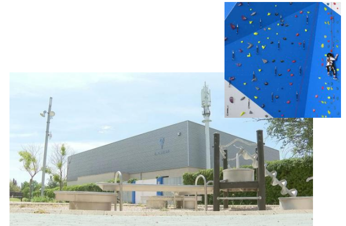
C. N. Helios (Zaragoza) VRF Hi-FLEXi 80CV – 229kW
