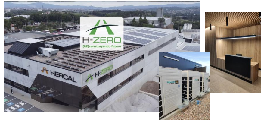
Oficina Hercal Diggers (Terrassa)
