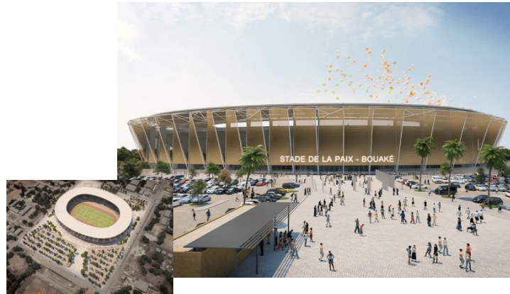
Estádio Bouaké na Costa do Marfim VRF Hi-FLEXi 311CV – 873kW
