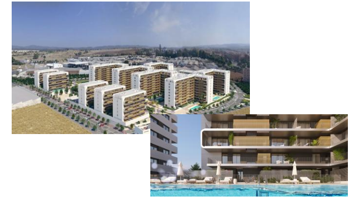
Kronos Homes 130 viviendas (Córdoba) CONDUCTO 390CV – 1.092kW
