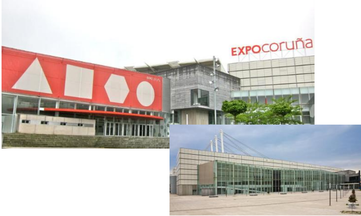
Recinto ferial IFECO (A Coruña) VRF Hi-FLEXi 290CV – 777kW
