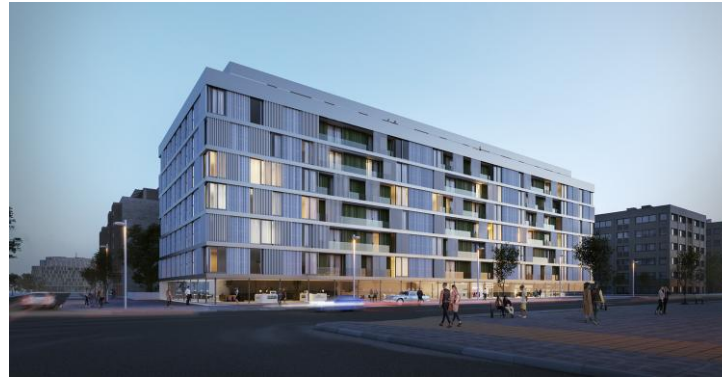
EMVS 116 viviendas Cañaveral (Madrid) Aeroterminia Hi-Therma 238CV - 666kW
