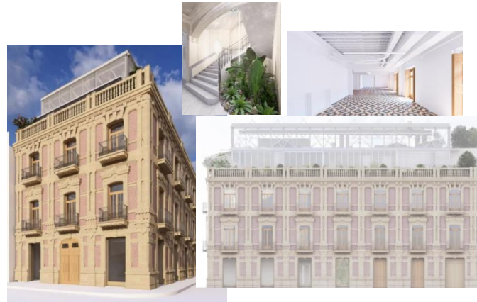
Casa Ruano Águilas (Murcia) VRF Hi-FLEXi 68CV – 193kW
