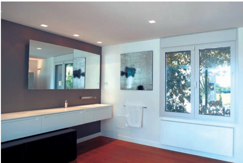
Foto 3.1. Radiador Jaga Low-H 2 O de baja masa y bajo contenido en agua, integrado en el diseño de una vivienda moderna.
