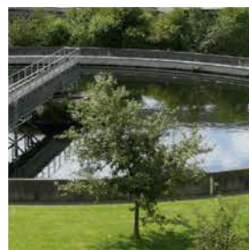
Tratamiento de agua
