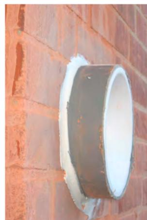
3. Colocar rejilla exterior atornillando las pestañas correspondientes y la tapa interior con los tacos de fijación a la pared.
