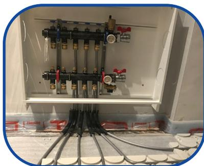
Dejar una pequeña zona delante del colector sin placa para poder salir con los tubos . Esta zona se igualará con el resto con el mortero auto-nivelante.
