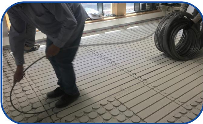
5.- Colocación tubo de los distintos circuitos.
