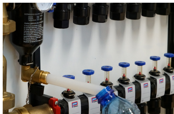
4. Abrir la llave de vaciado y sacar aproximadamente un litro de agua, posteriormente, cerrar la llave de vaciado.
