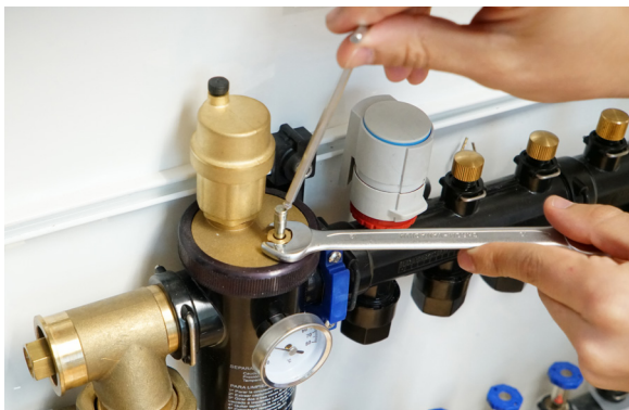
1. Desenroscar el tornillo de la parte superior del estrato.
