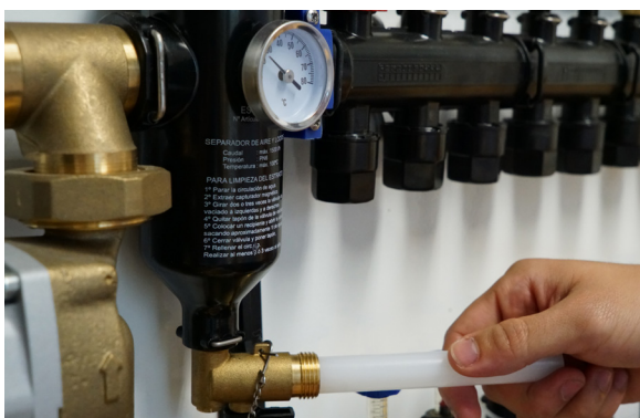
3. Pasados unos minutos girar la llave de vaciado de un lado a otro varias veces.
