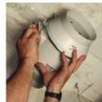
Colocar el cuerpo motor.
