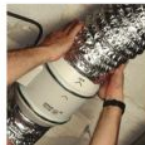
Acoplar los conductos.
