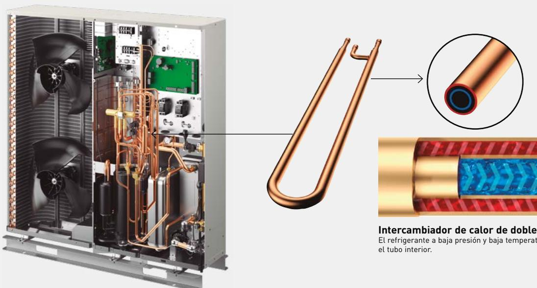
**Intercambiador de calor de doble tubo.**
