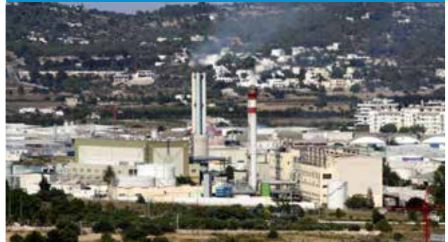
Central térmica GESA
