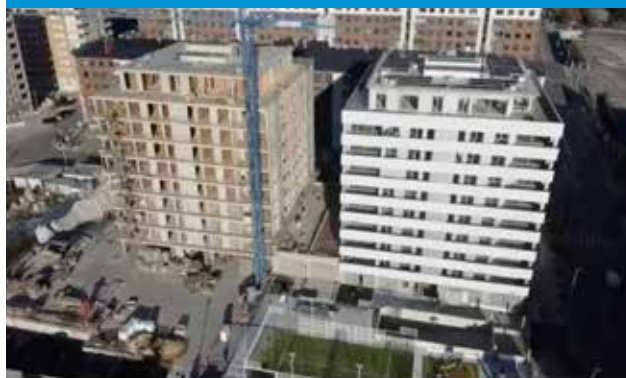
Residencial Cúbicos Viviendas
