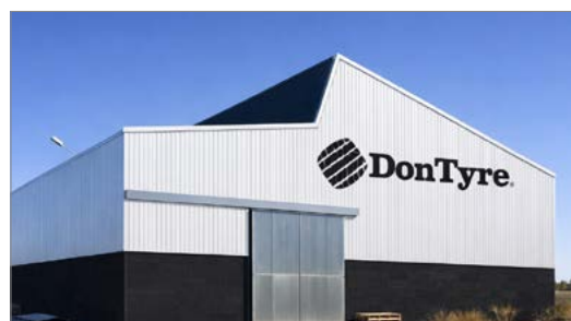
OFICINAS CENTRALES DON TYRE, Zafra GMV6 + CASSETTE 360°
