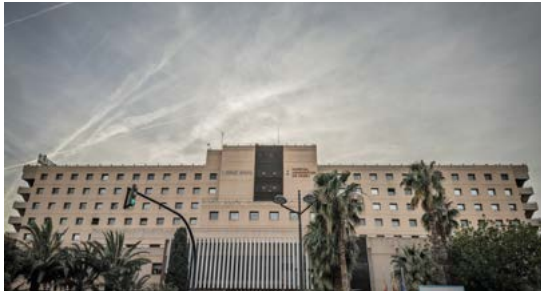
HOSPITAL DR. PESET, Valencia CHILLERS
