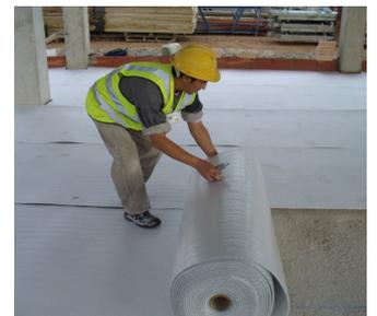
\*Combinación realizada entre aislante Air-bur Termic y un aislante de masa (lana mineral, XPS, EPS... de conductividad térmica 0,036 W/mk).
