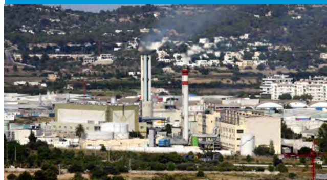
Central térmica GESA
