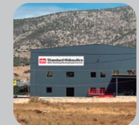
Hellas (Grecia, GR) Superficie 2.500 m2 Facilities / Installations
