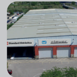
Montcada i Reixac (Barcelona, ES) Superficie 12.500 m2 Facilities / Installations
