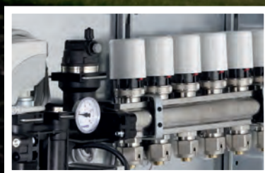
Distribución Calefacción y Refrigeración
