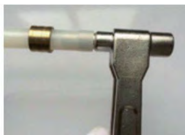
2. Abocardamos el tubo 2. Abocardamos o tubo
