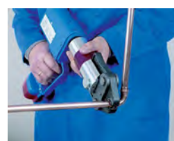
6. Prensado 6. Prensado
