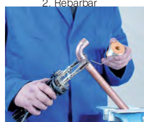
5. Aplicación de la soldadura 5. Aplicação da soldadura
