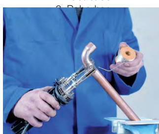
5. Aplicación de la soldadura 5. Aplicação da soldadura
