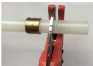
1. Cortar el tubo en ángulo recto. 1. Cortar o tubo em ângulo recto.
