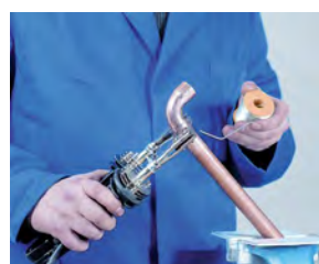
5. Aplicación de la soldadura 5. Aplicação da soldadura
