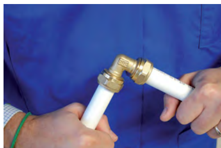
5. Montaje finalizado 5. Montagem terminado
