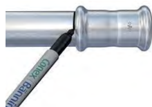
4. Marcar la inserción 4. Marcar ponto da inserção
