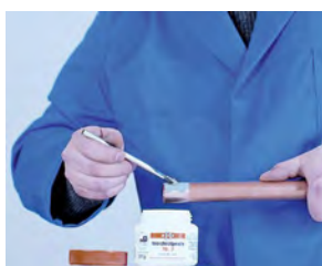
4. Aplicación del decapante 4. Aplicação do decapante
