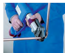
6. Prensado 6. Prensado
