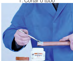
4. Aplicación del decapante 4. Aplicação do decapante
