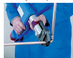
6. Prensado 6. Prensado
