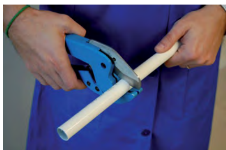
1. Cortar el tubo en angulo recto 1. Cortar o tubo em ângulo recto
