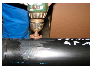
13. Repasar los orificios con una broca.
