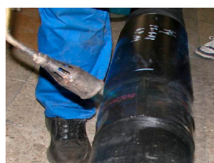
10. Calentar con la antorcha hasta que quede totalmente soldado.
