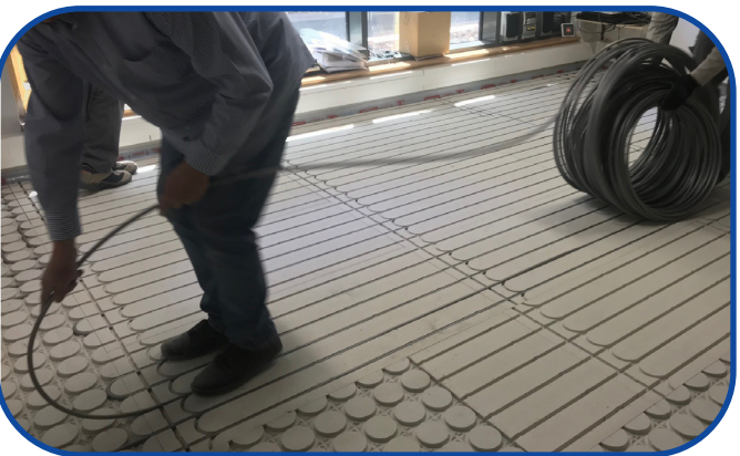
5.- Colocación tubo de los distintos circuitos.
