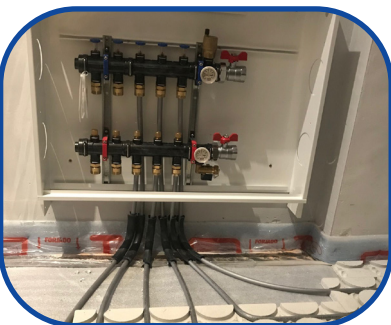
5.- Colocación tubo de los distintos circuitos.
