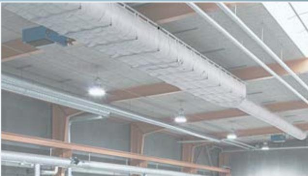
*Los conductos rectangulares suelen diseñarse con membranas internas a fin de favorecer la rigidez estructural. Asimismo, se pueden emplear aros de soporte en los cuatro laterales, lo que garantiza que el conducto mantenga su perfil cuando la ventilación esté encendida. De esta forma se evita que la presión natural lo deforme.*
