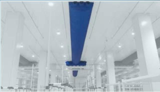
*Los segmentos circulares suelen instalarse en almacenes de gran capacidad y salas de servidores, ya que no requieren de mucho espacio para generar el flujo de aire perfecto. Al diseñarlos con flujos direccionales, estos perfiles de conductos garantizan una combinación excelente y una difusión de aire uniforme, a pesar de su reducido tamaño.*
