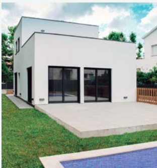
Casa pasiva de nueva construcción en Sant Cugat del Vallès (España)
