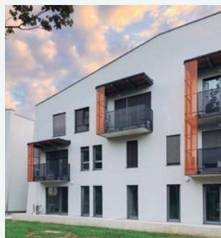
Vila blok Šubičeva: 25 apartamentos de lujo de bajo consumo energético en Maribor (Eslovenia)
