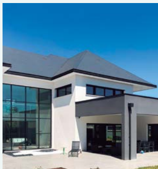
Casa de 610 m 2 con suelo radiante y ACS en Saint-Prest (Francia)
