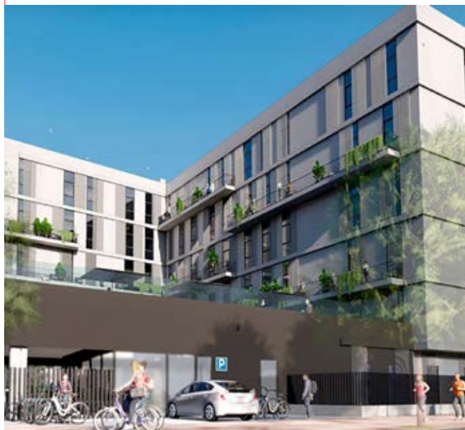
Residencia de estudiantes, Cartuja Life (Sevilla) Sistema Instalado: KXZ (VRF)
