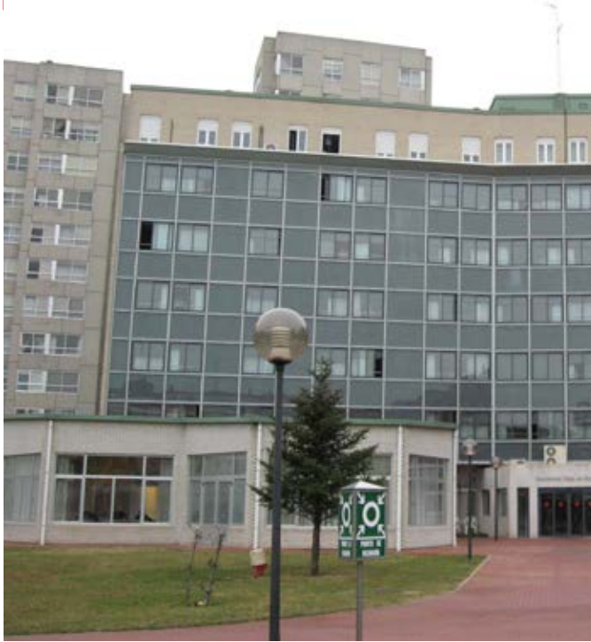
Residencia Fundación Caja Burgos (Burgos) Sistema Instalado: Q-ton Bomba de calor con CO 2 , KXZ (VRF) y Recuperadores
