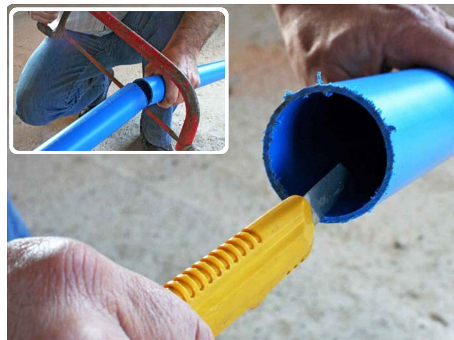
Extracción de rebarbas causadas por el corte con sierra >
