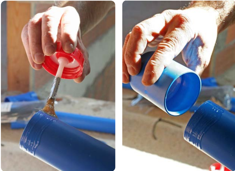
< Aplicación correcta del adhesivo
