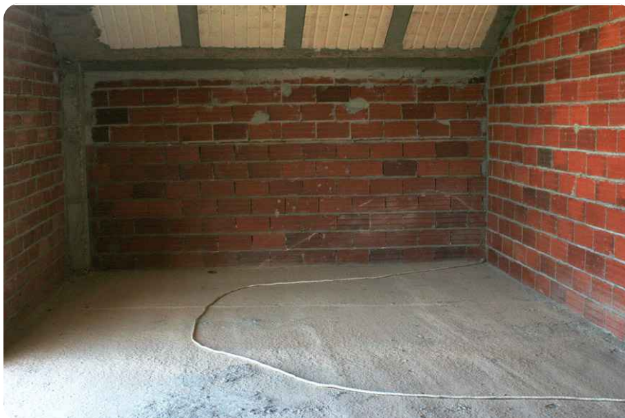
< Medición en obra
