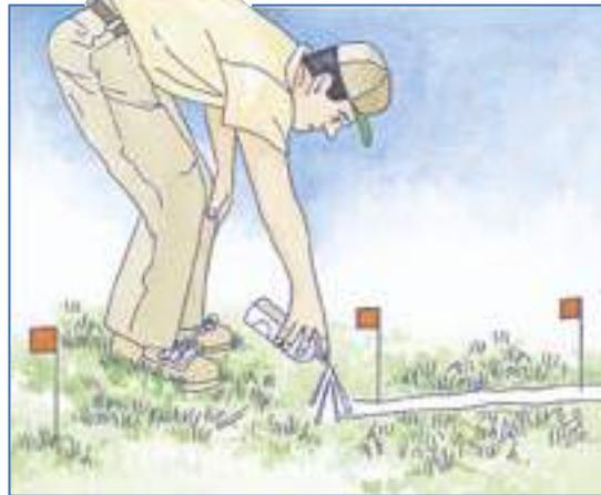
Antes de hacer la zanja, utilice pequeñas banderas y pintura en aerosol para marcar para hacer un esquema del sistema de riego.
