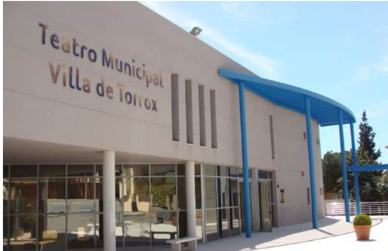
Teatro Municipal Villa de Torrox Malaga, Spain
