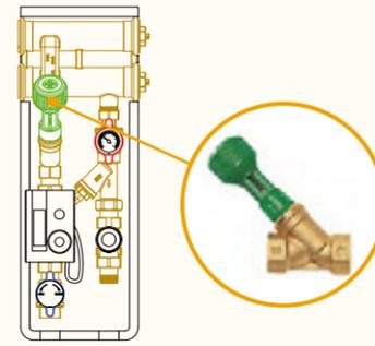
Con válvula alto Kv y equilibrado estático
